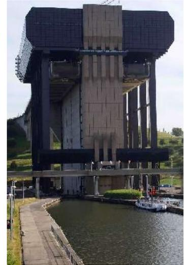
Les 2 bacs de 112 x 12 m évoluent indépendamment l'un de l'autre et peuvent accepter des bateaux de 2 000 t<sup>1</sup>. Chacun pèse 8 000 t<sup>2</sup> et est suspendu à 144 énormes câbles<sup>3</sup>, dont 112 supportent 8 contrepoids de 1 000 t, les 32 autres étant entraînés par 4 moteurs électriques de puissance relativement faible (510 kW, soit l'équivalent d'un moteur d'une F1).
